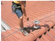
PUNTO DE ANCLAJE INTERMEDIO CON PASO CONTINUO.
