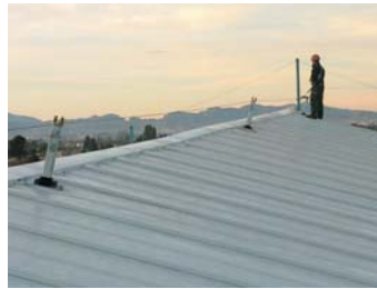
FLEXIBLE MONOCABLE SOBRE POSTE EN CUBERTA.
